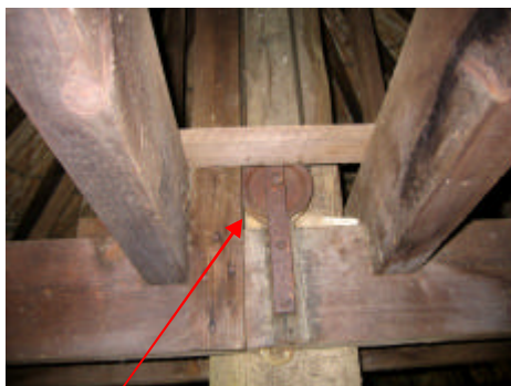
katrol bevestigd aan kruishout
